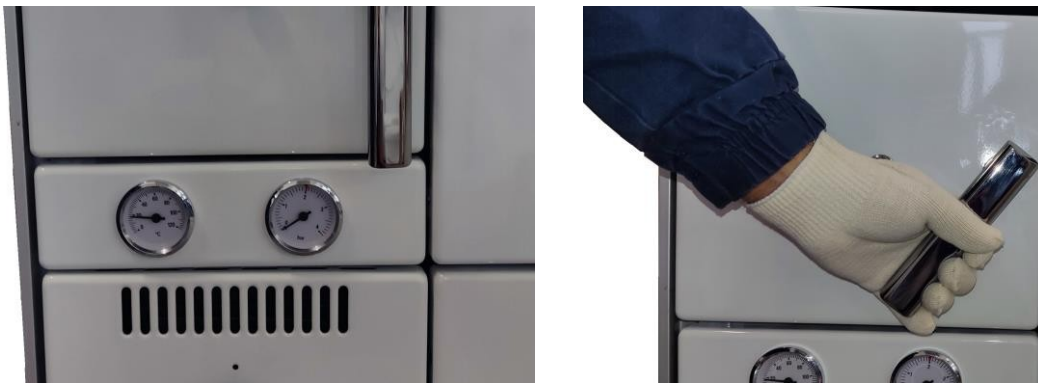
Kuva 8. Kattilan lämpö- ja painemittari sekä palamisensäätimen nupin käyttö.
