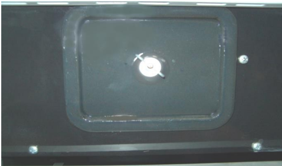
Kuva 13. Puhdistusaukon sisäkansi suojakannen takana.
